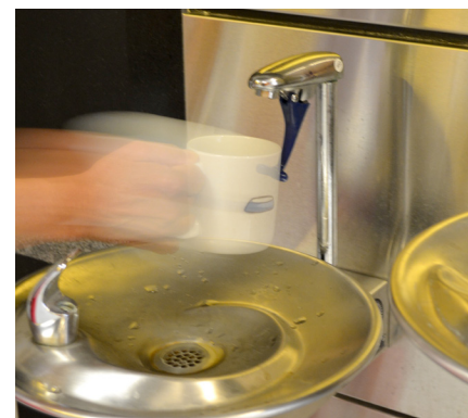
Fontaines permettant le remplissage facile des verres ou des tasses, un incitatif à réduire l'achat de bouteilles d'eau.
