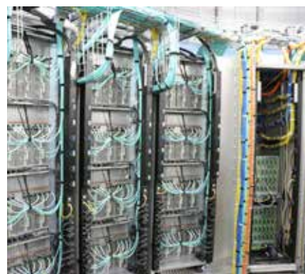
La chaleur de la salle de serveurs, située dans le Colosse, est récupérée par le réseau d'eau refroidie pour chauffer d'autres pavillons du campus.
